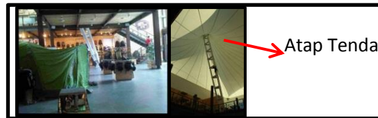
Gambar 20. Elemen Horizontal Atas Pada Interior Bangunan
