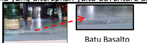
Gambar 19. Material Lantai Pada Interior Bangunan
