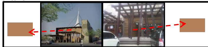
Gambar 17. Penggunaan Warna Pada Fasade Bangunan
