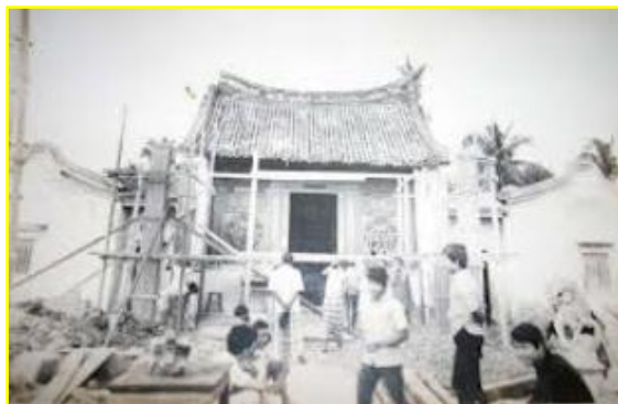
Gambar 2. pembangunan salah satu bangunan oriental tempo dulu Sumber: ceriterasangkurakura.blogspot.com
