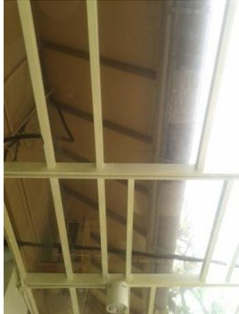
**Gambar.23** *Skylight* pada area teras samping
