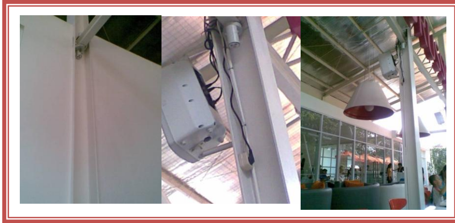
Gambar 3.10 Plafon Area Lantai Brussels Springs Resto and Café (Sumber: Dokumentasi Pribadi)
