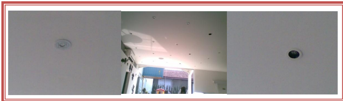
Gambar 3.9 Plafon Brussels Springs Resto and Café (Sumber: Dokumentasi Pribadi)
