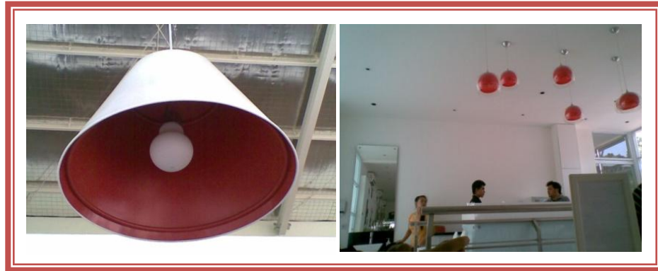
Gambar 3.7 Plafon Area Lantai 2 Brussels Springs Resto and Café (Sumber:Dokumentasi Pribadi)
