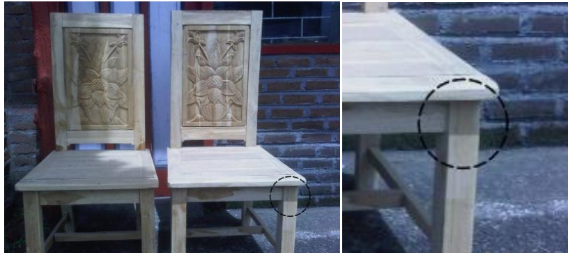
Gambar 13. sitem sambungan menggunakan Sambungan Pen (Tidak Tembus) dengan Spat Pen Tersembunyi (DoK. Pribadi)
