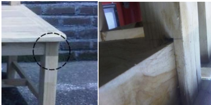
Gambar 11. sistem sambungan menggunakan Sambungan Pen (tidak tembus) dengan Spat Pen Tersembunyi (sumber, dok. pribadi)
