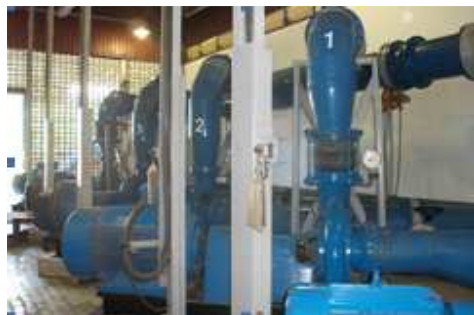
Gambar 2.5. Instalasi Pompa Distribusi IPA Kampung Damai
