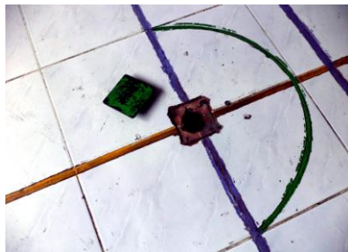
Gambar 4.10. Desain Modifikasi Lubang Penanaman Tiang Untuk Olahraga Badminton, Bola Voli dan Lompat Tinggi pada Fasilitas Sport Court Multi Fungsi
