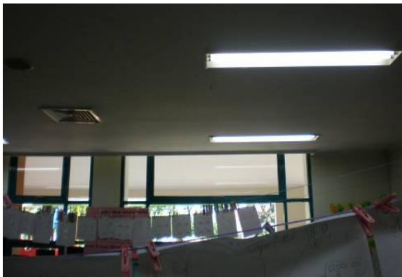
Gambar 4. Plafon ruang kelas
