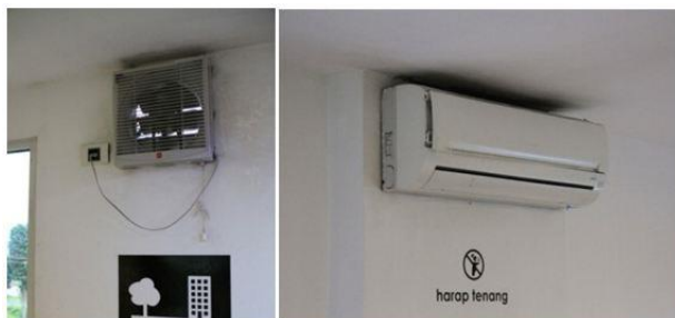
Gambar 5. Penghawaan Buatan yang Ada di Seluruh Ruang Biru, Merah dan Kuning Berupa Exhaust Fan dan AC
