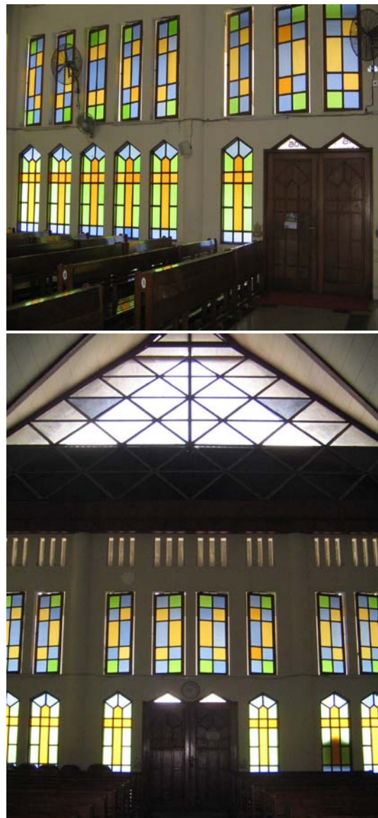
Gambar 3. Dinding nave bagian Timur altar Gereja Redemptor Mundi
