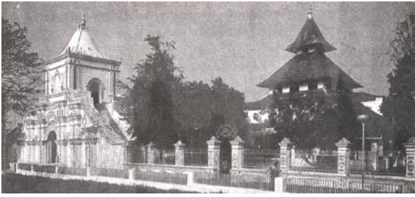
Gambar 5. Pintu gerbang Masjid Jamik Sumenep yang bentuknya mirip dengan tembok Raksasa Tiongkok. Dilatar belakang nampak bangunan masjidnya yang beratap Tajug tumpang tiga pengaruh arsitektur Jawa – Islam (Sumber: Dokumentasi Pribadi).
