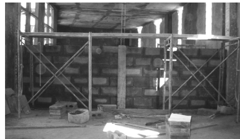
Gambar 1. Kondisi Lapangan Pekerjaan Student Center ITENAS, Bandung (Sumber: tim peneliti, 2003)
