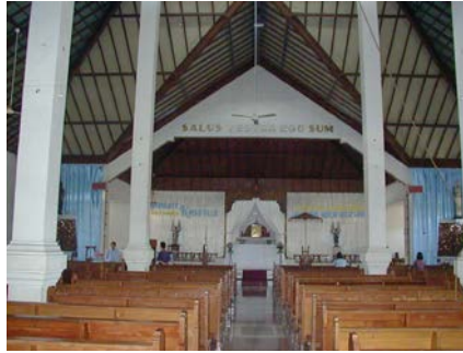
Gambar 4. Tampak interior ke arah altar, terlihat empat saka guru yang menyokong struktur atap (Sumber: dokumentasi pribadi, 2004)
