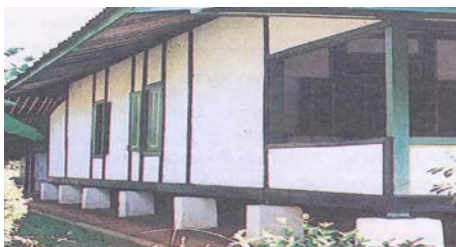
Gambar 17. Struktur Tiang Rumah Tradisional Sunda (Sumber: dokumentasi penulis, 2006)
