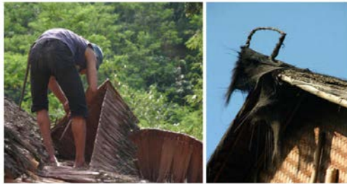
Gambar 15. Bentuk Atap dengan Material Ijuk (Sumber: dokumentasi penulis, 2006)
