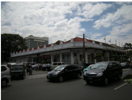
Gambar 19. Bangunan sudut Jl. Braga –Jl. A-A sekarang (Sumber: dokumentasi pribadi)
