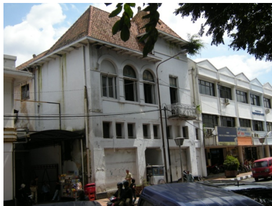
Gambar 14. Gedung bekas Aubon Marche, terdapat pohon di atap (Sumber: dokumentasi pribadi)
