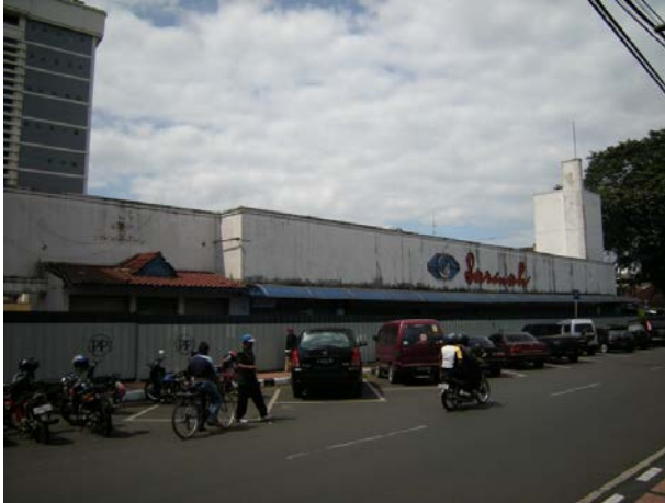
Gambar 22. Lahan bekas Sarinah yang baru dibongkar.(selatan Jl. Braga) (Sumber: dokumentasi pribadi)
