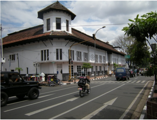
Gambar 12. Bangunan bekas “De Vries” tertinggal dinding muka saja (Sumber: dokumentasi pribadi)
