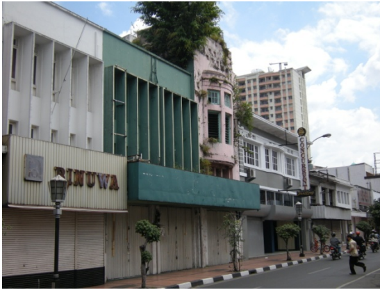
Gambar 15. Bangunan bekas “Modern Foto”, terdapat pohon beringin di atap (Sumber: dokumentasi pribadi)
