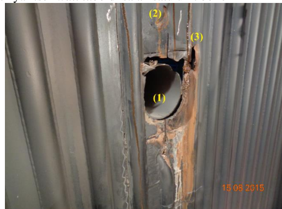
Gambar 1. Riser wall tube yang mengalami kegagalan
