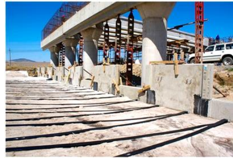
Gambar 14. Pemasangan Paraweb Straps
