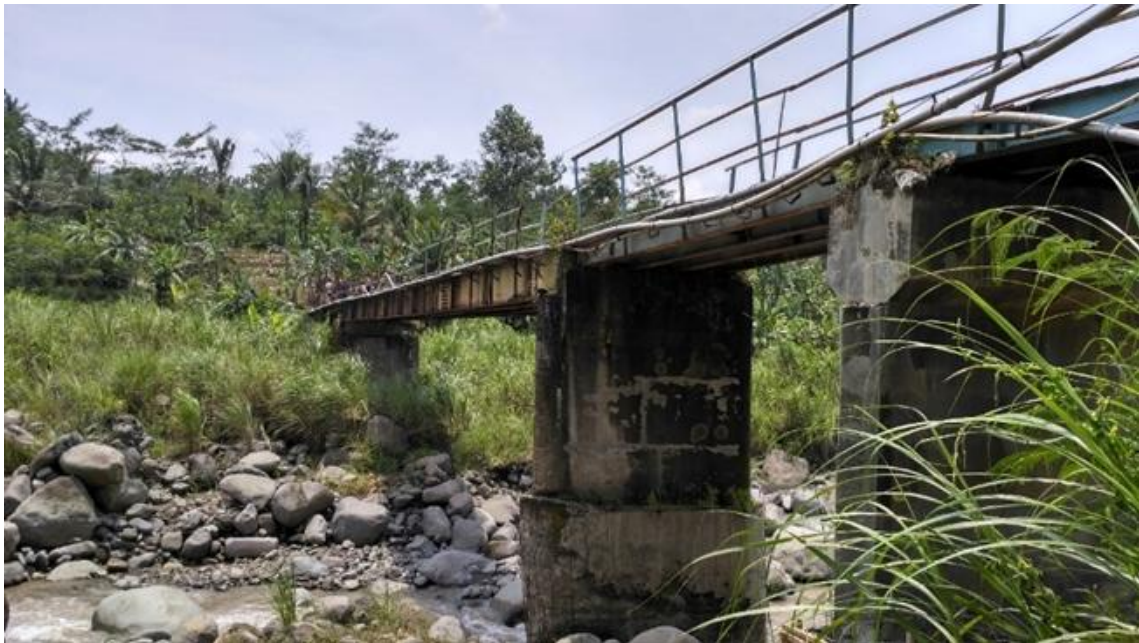
Gambar 1. Situasi Jembatan Plompong, Brebes
