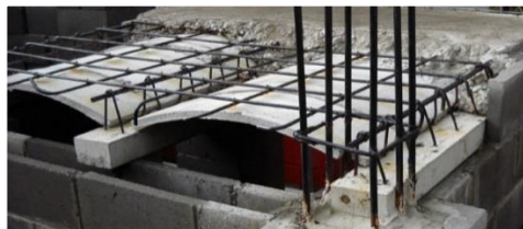
Gambar 2 Precast Pendukung Pelat (Support Beam)
