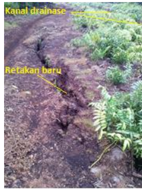
Gambar 3.6 Titik Keruntuhan Baru pada Lereng ( \pm 463 m dari Pantai)
