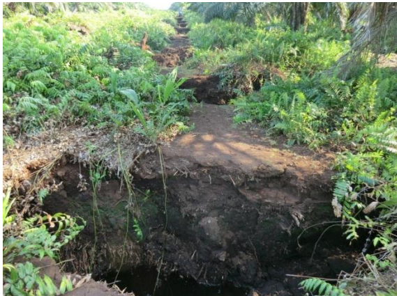
Gambar 3.7 Titik Keruntuhan Baru pada Lereng ( \pm 463 m dari Pantai)
