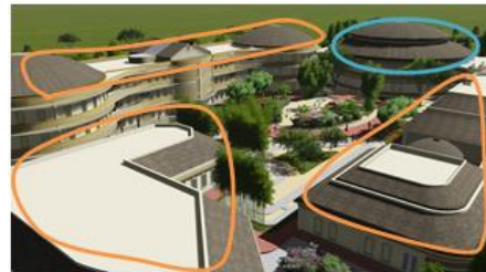
Gambar 23. Atap Datar pada Bangunan Hasil Pengembangan Desain, 2015
