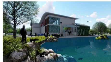
Gambar 27 Fasad Gedung Puskesmas
