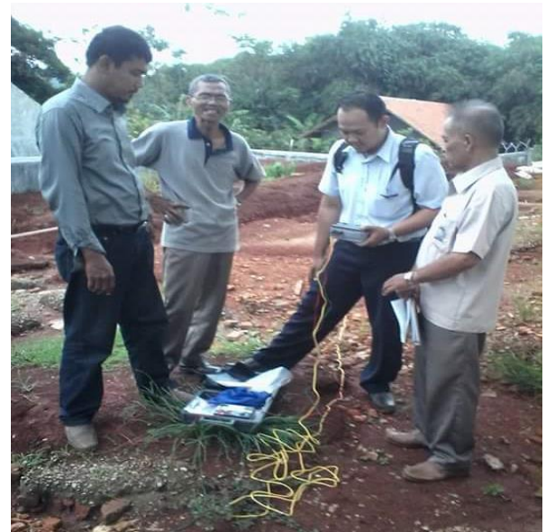
Gambar 12. Pengukuran pentanahan di area cakupan 3
