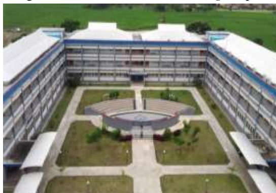
Gambar 12. Lokasi pengujian remote
