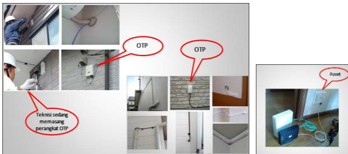
Gambar 10. Pemasangan OTP pada Jaringan Pelanggan FTTH Hasil Joint Experience Antara Telkom Akses dan Fujikura
