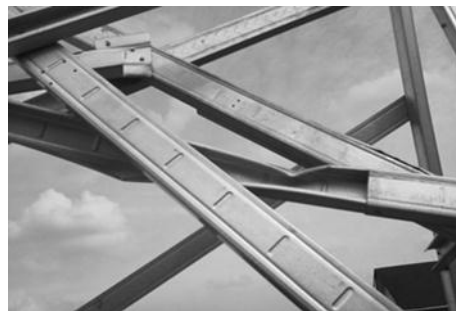
Gambar 5 Tekuk lokal pada struktur kuda-kuda profil C tunggal
