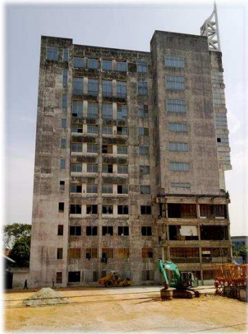
Gambar 3 Kondisi bangunan eksisting
