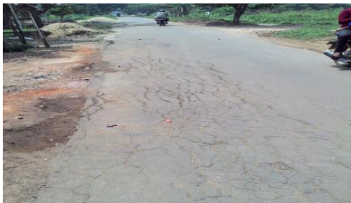
Gambar 9. Retak Kulit Buaya
