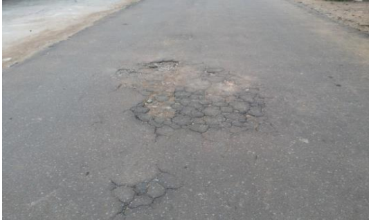
Gambar 7. Retak Blok
