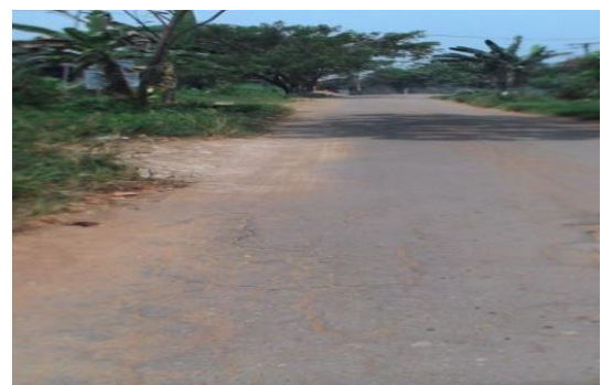
Gambar 6. Retak Pinggir
