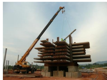
Gambar 4.5 Pemasangan beban lokasi 1
