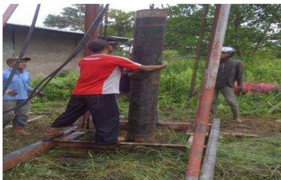
Gambar.3. Pemasangan casing besi
