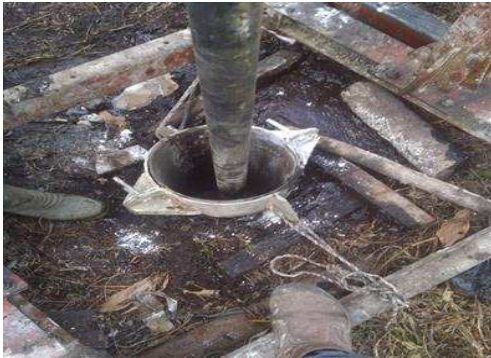
Gambar.5. Jumlah injeksi pada tiap satu kolom-
