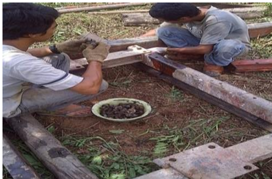
Gambar.2. Proses perakitan alat bor pile
