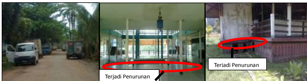
Gambar 1: Truk-truk yang singgah di jalan utama dan penurunan pondasi pada area tertentu Taman Gitananda Pontianak
