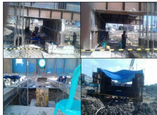
Gambar 2 Pengujian beban statis (SLT) Sumber: PT. Trimatra Jaya Persada (2016)
