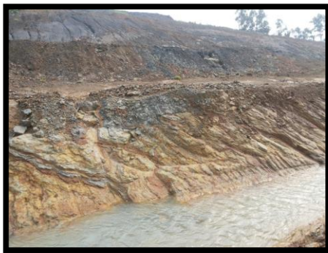
Gambar 1. Kenampakan litologi TAL Utara, tersusun oleh batupasir agak lapuk ( Slightly weathered ) di bagian atas dan Batulempung di bagian bawah
