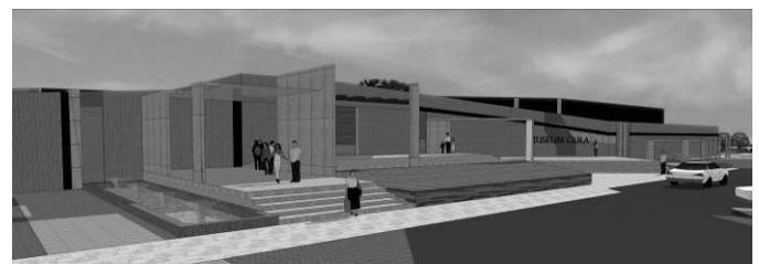
Gambar. 7. Tampak Bangunan dari Barat (Entrance)
