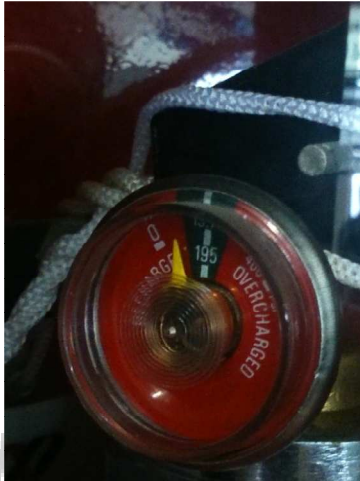
Gambar 2. Kondisi APAR yang terindikasi kerusakan
