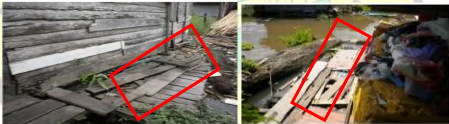
Gambar 13. Kerusakan Pada Elemen Lantai
