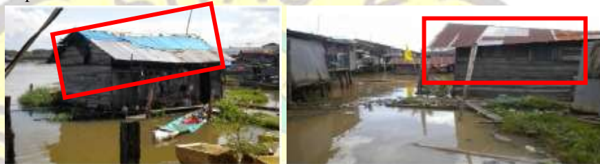
Gambar 14. Kerusakan Pada Elemen Atap
