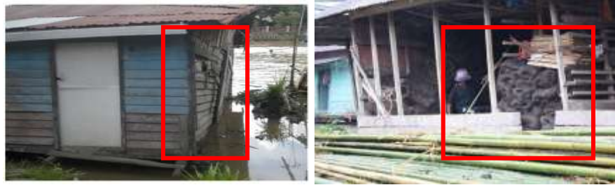
Gambar 13. Kerusakan Pada Elemen Kolom dan Dinding
