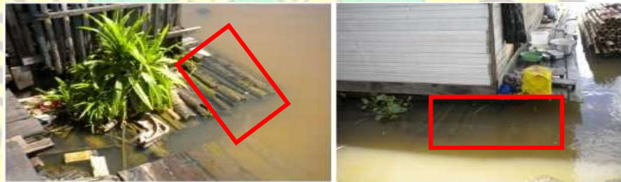
Gambar 12. Kerusakan Pada Bagian Pondasi
