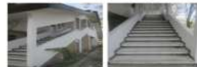
Gambar. Tangga pada balok-balok gedung
