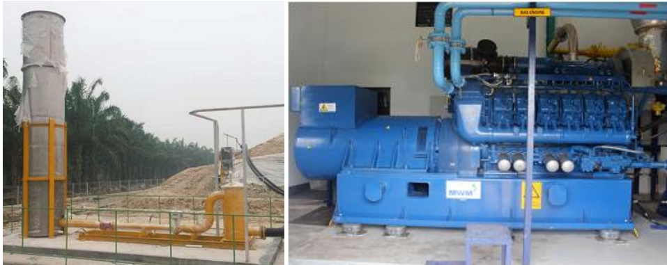
Gambar 5. Flare (kiri), Gas Engine (kanan)
