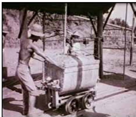
Gambar 3a: Kuli dengan lori di jembatan timbang, Tambang Timah Biliton.
