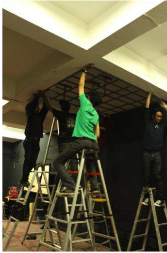
Gambar 3.8 Proses pemasangan rel besi di langit-langit ruang pameran
