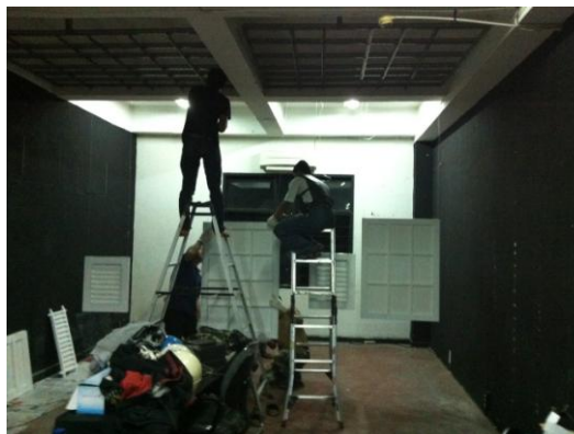
Gambar 3.12 Proses instalasi karya
