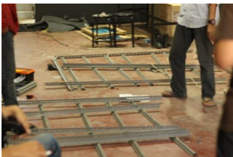
Gambar 3.7 Proses perangkaian rel besi dan hasil rangkaian rel besi
