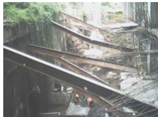
Gambar 9. Perkuatan Sementara D-wall yang Bengkok.
