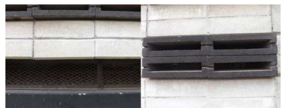
Gambar 5. Cross ventilation pada rongga-rongga dinding masjid
