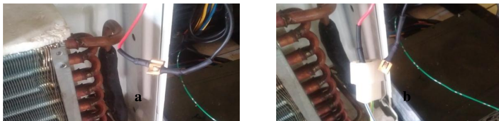
Gambar 10. Pengujian wiring dengan cara a= mengkonsletkan dan b=mencopot kabel
