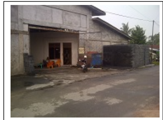
Gambar 5. Kondisi gudang material
