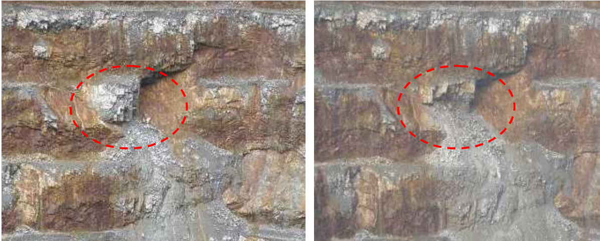
Gambar 8. Hasil pembacaan radar – terlihat peningkatan pergerakan sebelum terjadi ketidakstabilan
