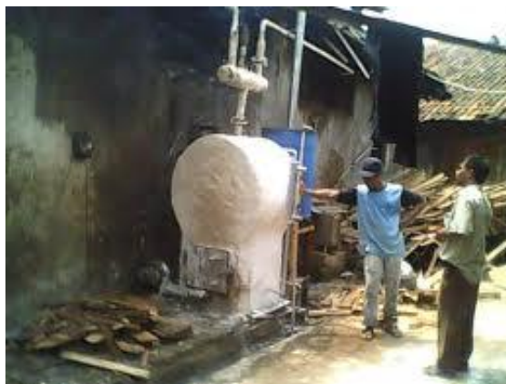
Gambar 1. Boiler di Industri Tahu Tempe
