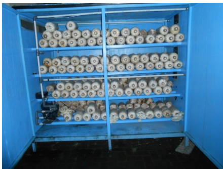
Gambar 2. Kumbung Jamur dan Instalasi Pipa Pengkabutan.
