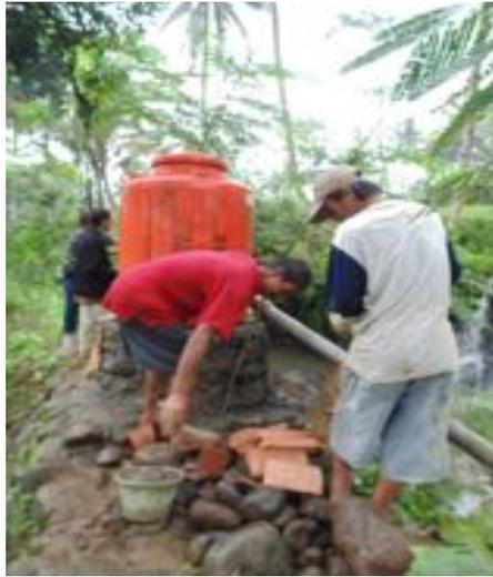
Gambar 7. Perbaikan instalasi pompa hidram.
