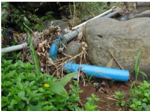
Gambar 4. Kondisi instalasi pompa hidram yang rusak akibat luapan air sungai.
