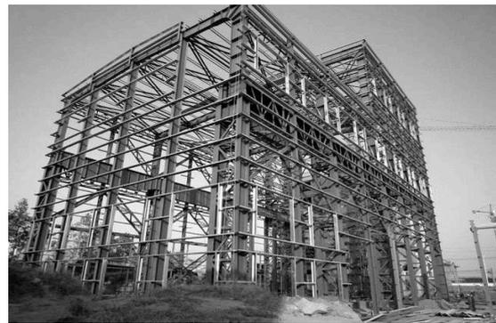
Gambar1. Contoh Bangunan Kerangka Baja
