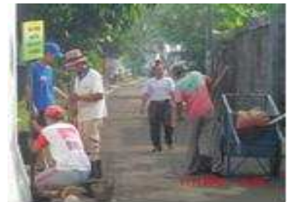
Gambar 6. Pemasangan plang sebagai rambu-rambu moral
